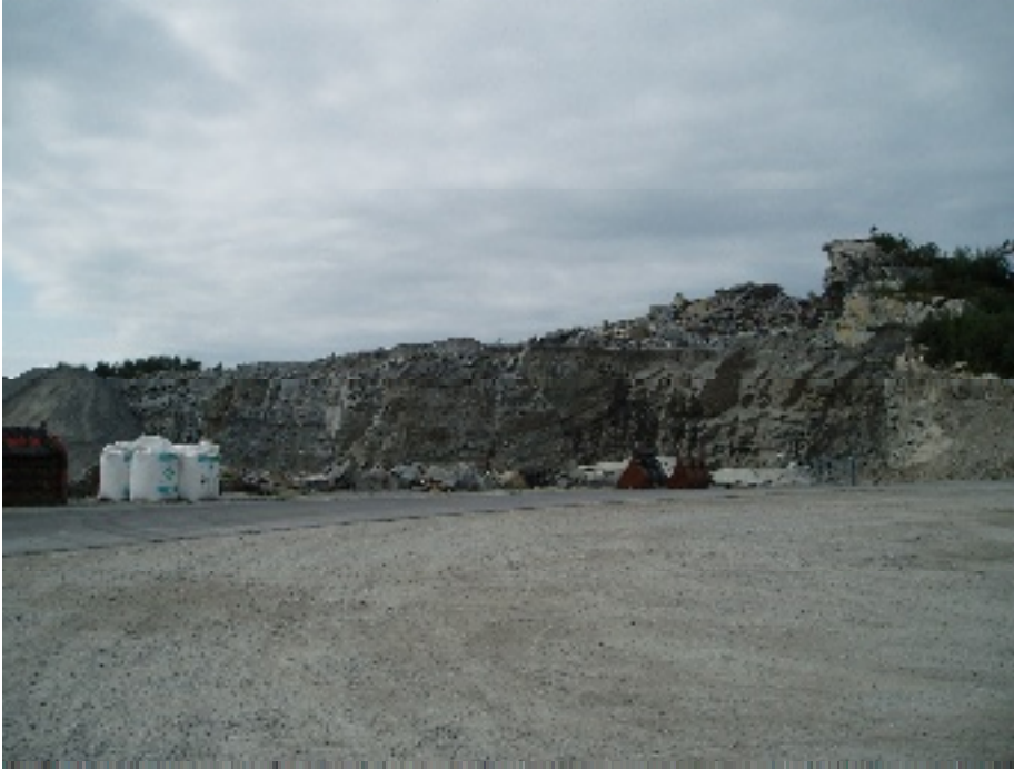
Anslutande stenbrott i söder.
